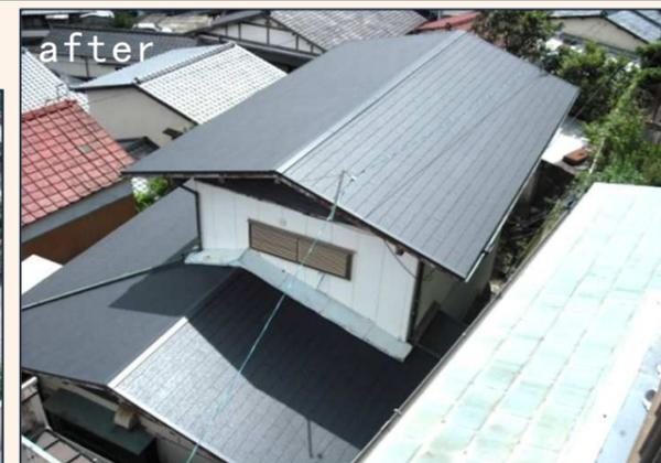
劣化した屋根からの雨漏れ・内部の腐食を解消するため、セメント瓦からコロニアルへ葺き替えました。また、被害にあった内部も改修対象となります。
