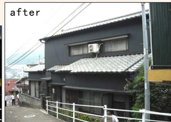
室内の改修に加え、劣化等によって不適合とされた外壁・雨樋・板金の工事をしました。建物全体にわたり、しっかりと耐震基準に適合させました。
