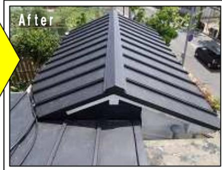
既存セメント瓦から、瓦棒屋根に葺き替えました。既存セメントが経年劣化により、雨漏れが心配でしたが、屋根に下地補強をし、頑丈にしました。
