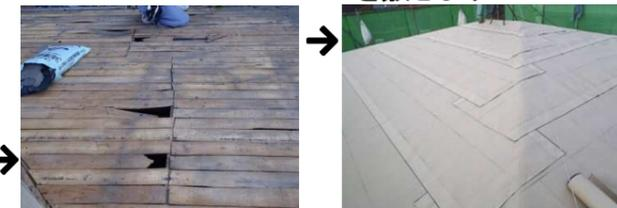
屋根の塗装が当初のご要望でしたが調査の結果、築40年セメント瓦の手入れをされていなかったので、この機会に防災瓦への葺き替えをおススメしました
